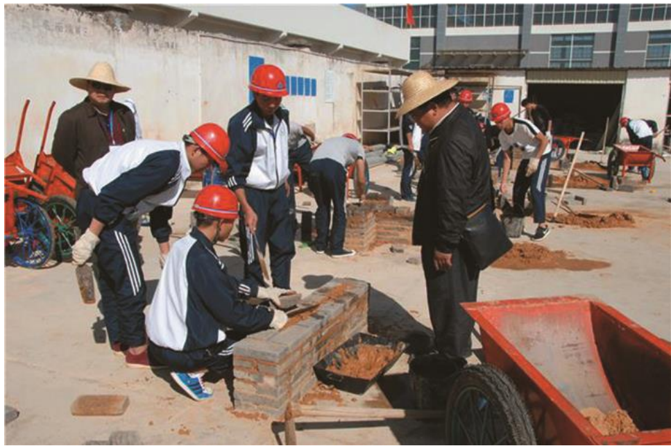
建筑施工实训
